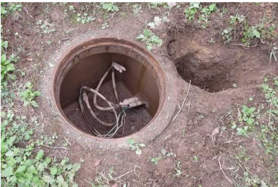
で、ハンドホールまで延伸、ハンドホールのコンクリート壁にはジャバラ管がギリギリで通るだけの穴を開けて、蛇腹管をハンドホール内へと突き出しました。
