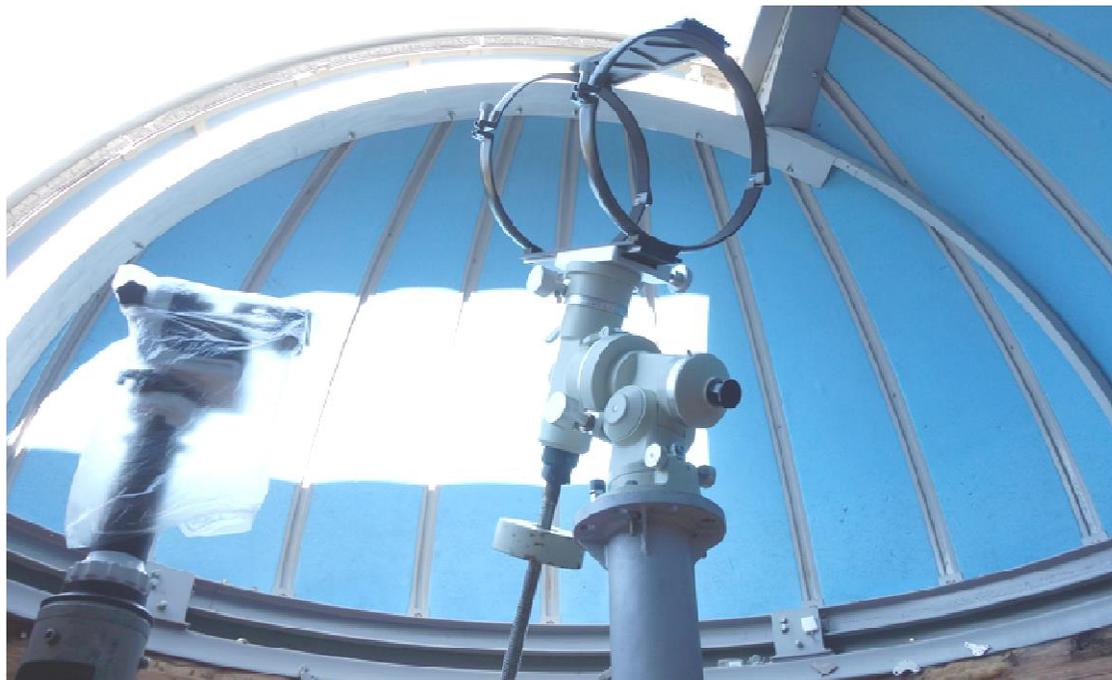
2016年の熊本地震のため大きな被害を被ったドーム内設備を 8月にやっと復旧させた。一番の問題は望遠鏡の設置だった。被災前は床にブロックを積み、その上にピラーを載せていた。モルタルで固定していたとはいえ、ほぼ地球の重力で安定を保っていた状態だった。これでは震度 6強の揺れに耐えられなかったのは当然といえる。故に、原状復帰は問題外で、地震に強い設備に更新しなければならない。望遠鏡を片付け、床を剥ぎ、ブロックを砕き床を綺麗にすることから作業を始めた。
